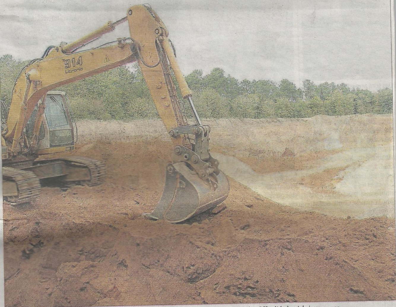
À Nort-sur-Erdre, le projet de sablière (ici photo d'une carrière dans la Sarthe) rencontre des difficultés à voir le jour. Photo DR
