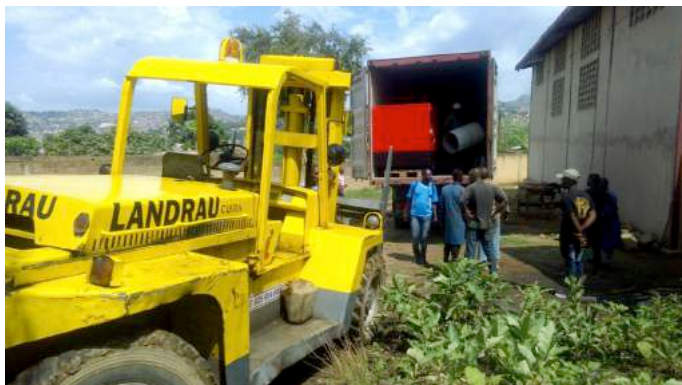
Déchargement de la génératrice
