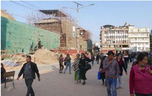
2018 Restauration en cours
